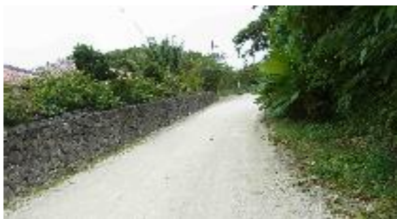
環状線から内側に入った白砂の道路
