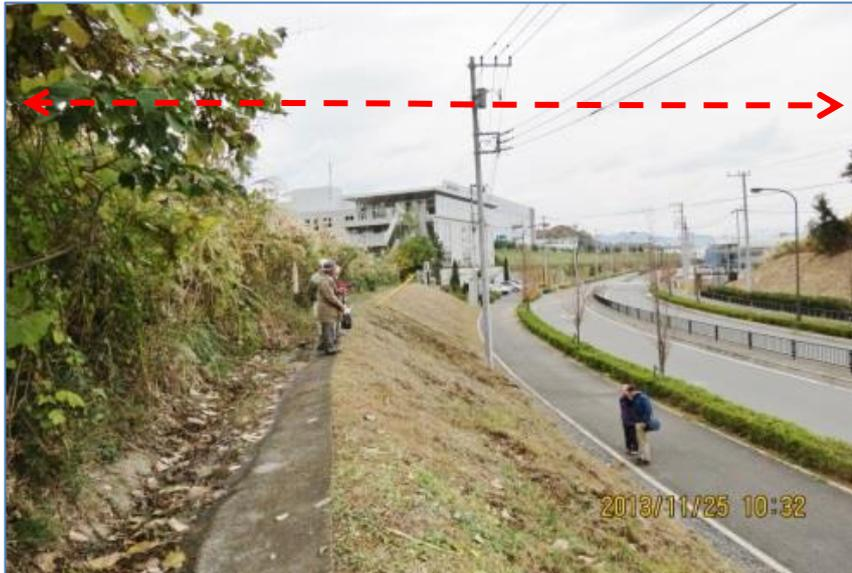
3;図は 2： 図で、保育園の北側を東西に走る道路の東側から奥にある保育園を撮影したものです。保育園は道路から左側に 6mほど上にあります。この道路は、2:図の黄色の破線の所の高さ 10m程の尾根をほぼ直角に横断して切り崩し造成されたものです。赤い破線が削られる前の尾根の頂の位置です。
