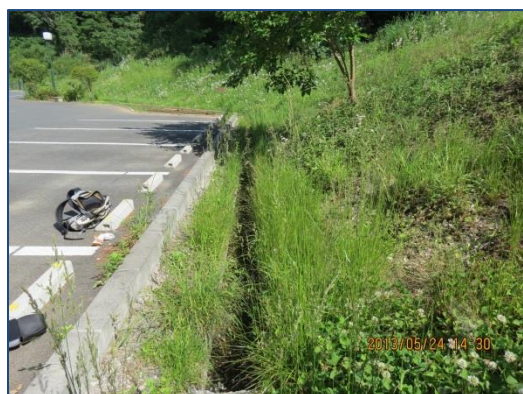
3：図 U字溝のある所の状況
