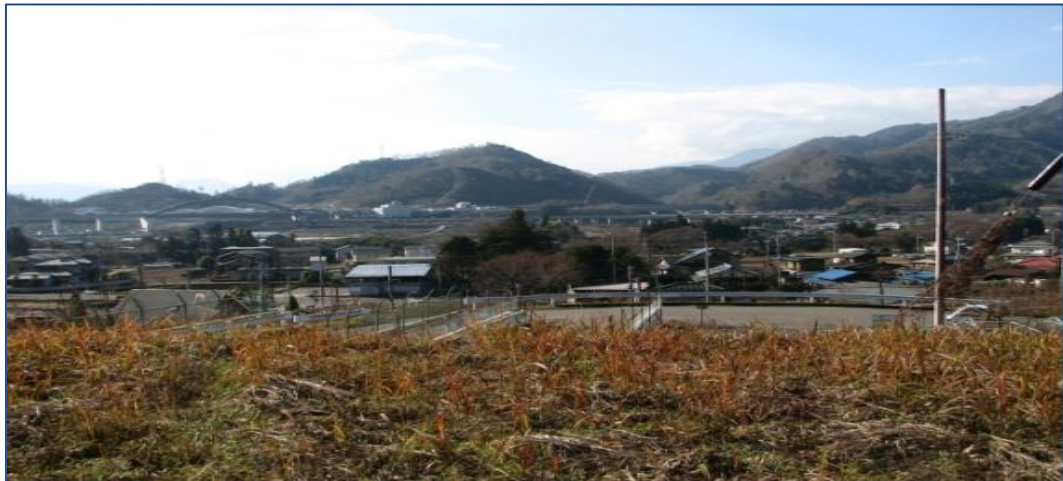
中央左手寄りが、リニアー実験線と見学センター。高川は中央右寄りの鞍部のところ。
